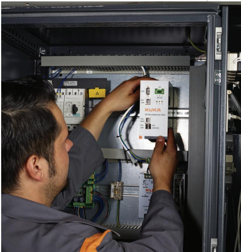
Ein kleiner silberner Kasten ermöglicht die Ferndatenübertragung. Nur etwa so groß wie zwei dicke Reiseführer ist er das Herzstück des KUKA-Teleservice, sammelt die Daten der Maschine bzw. der Anlage. Dies funktioniert über eine schnelle Internetverbindung, sei sie nun via Kabel oder Surfstick und einem VPN-Tunnel. Mit einem Passwort kann sich der KUKA-Servicetechniker auf dem KUKA-Teleservice-Server einloggen, die Daten einsehen und eine Online-Fehlerdiagnose stellen.
